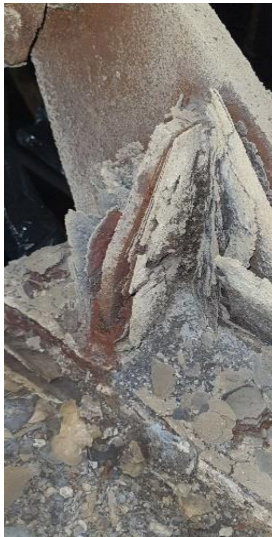
تصویر ۱ خوردگی شدید در محل اتصال پایه دمپر با سازه
